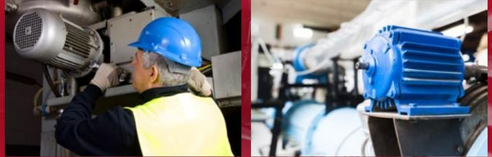
Prueba **todos los tipos de motores de corriente alterna** (de cualquier tensión), incluyendo los de inducción, sincrónicos, y los motores monofásicos. Se evalúa el estado eléctrico de todos los componentes del motor, incluidos los bobinados del estator y el rotor; conexiones y cables asociados.
