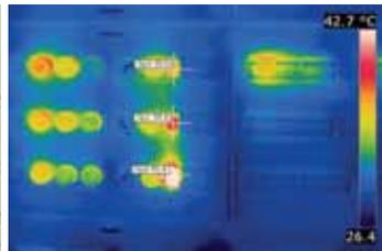
*Esta termografía muestra que la carga no está uniformemente distribuida entre las cajas de fusibles.*
