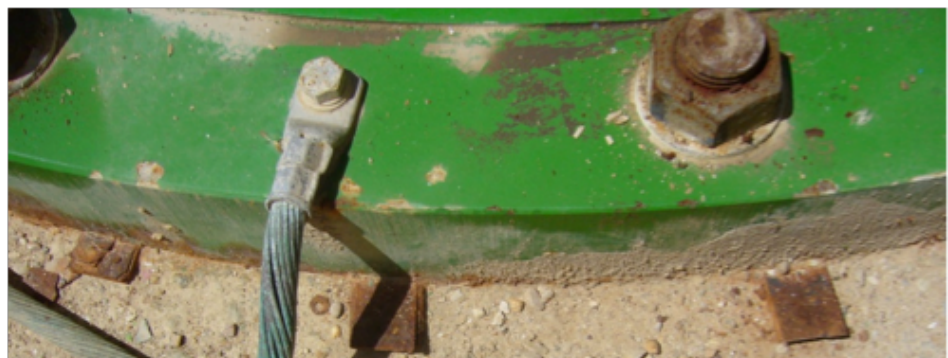
Foto 1.-Detalle placas niveladoras con la bomba montada
