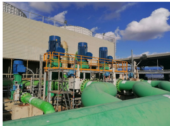
Figura 1: Bombas de refrigeración
