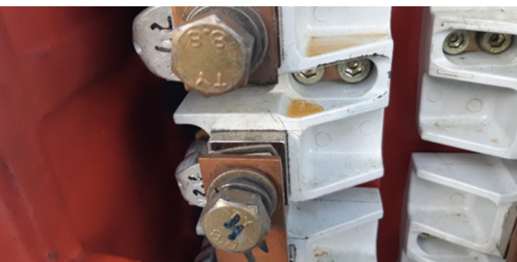
Figura 3: Bornero con evidencias de alta humedad
